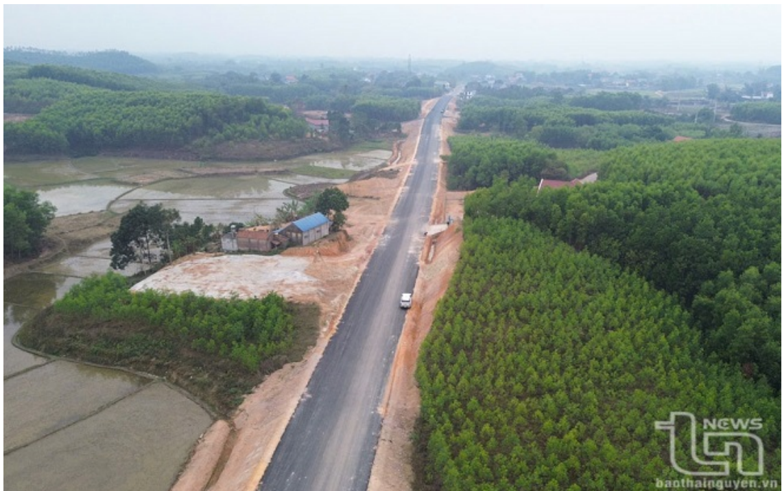
TP. Sông Công đầu tư trên 1,3 tỷ đồng cải tạo đường nội thị
