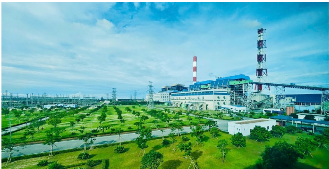
Nhà máy Nhiệt điện Thái Bình
