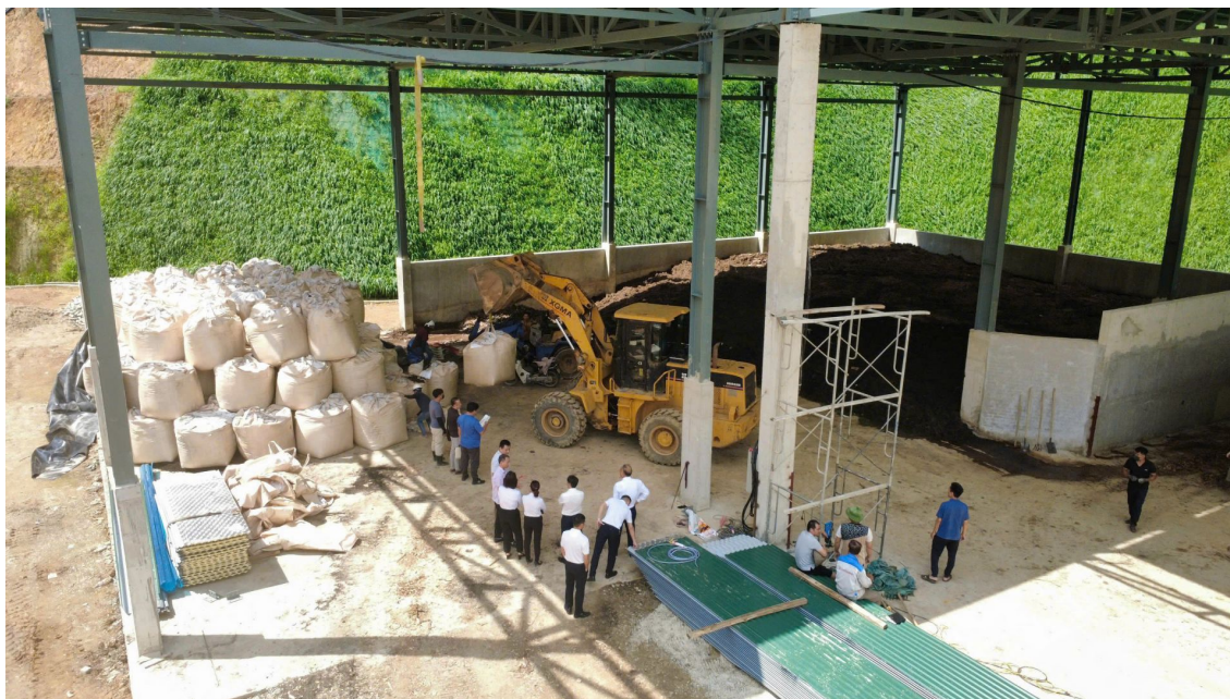
Khu nhà xưởng, khu tập kết nguyên liệu và hạng mục lên men đang được hoàn thiện, hướng tới công suất tối đa 50 tấn/ngày đêm
