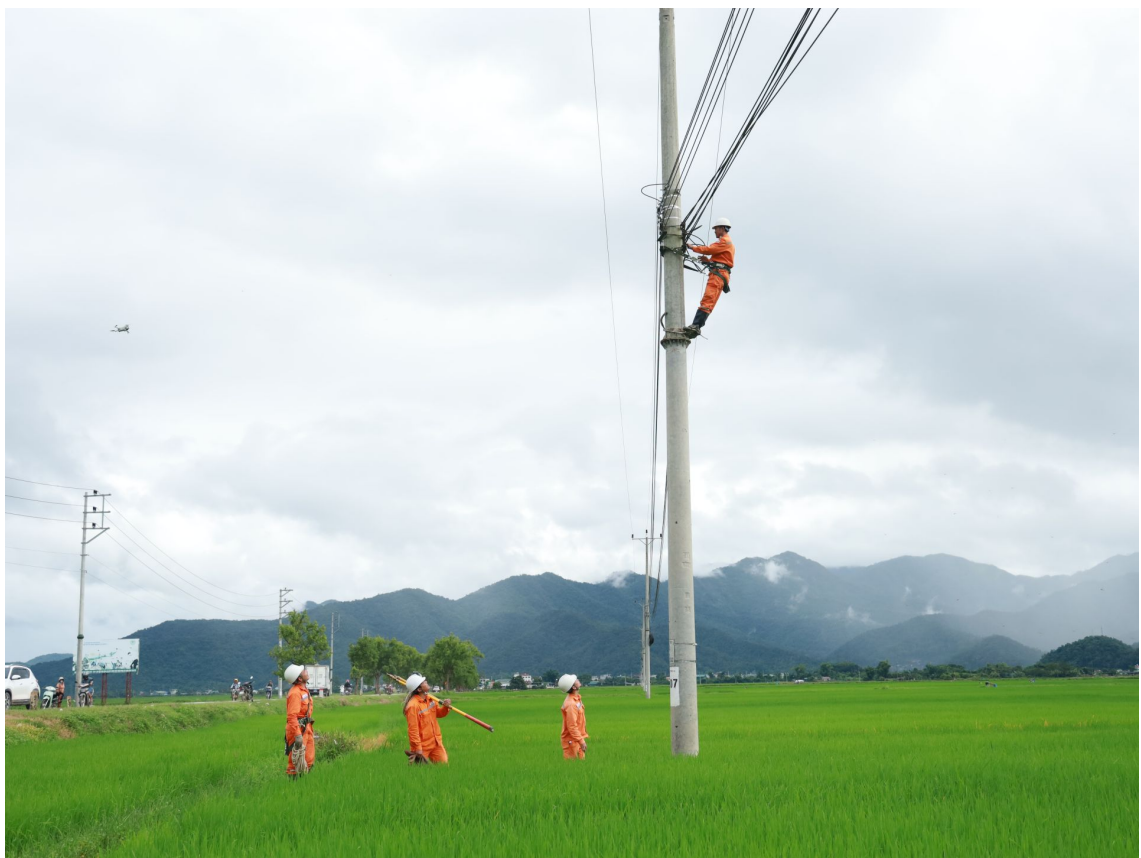
Công nhân quản lý vận hành kiểm tra, xử lý đường dây tại khu vực nông thôn
