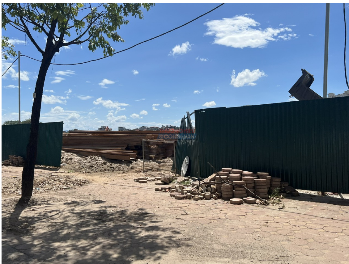
Gạch đá chất đống ngay tại vỉa hè, phía ngoài công trình
