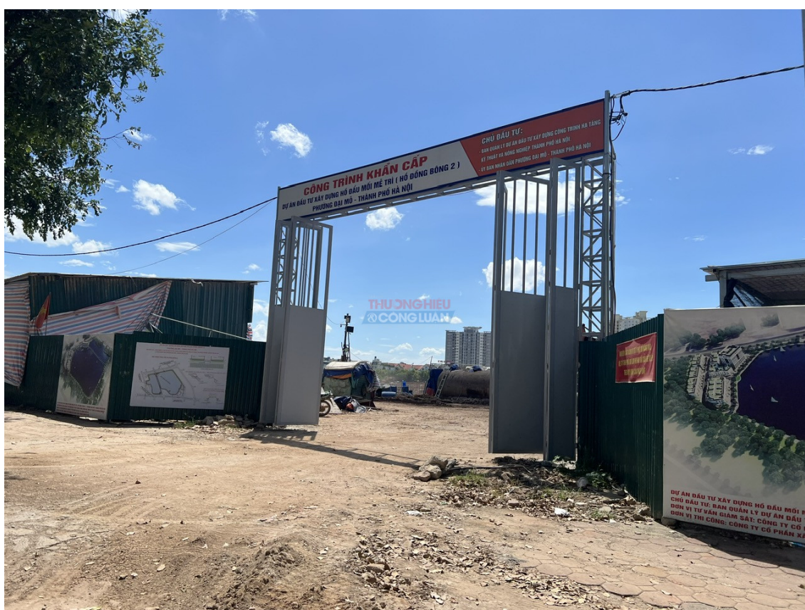
Đây là cổng công trình trên đường Tố Hữu, phường Đại Mỗ
