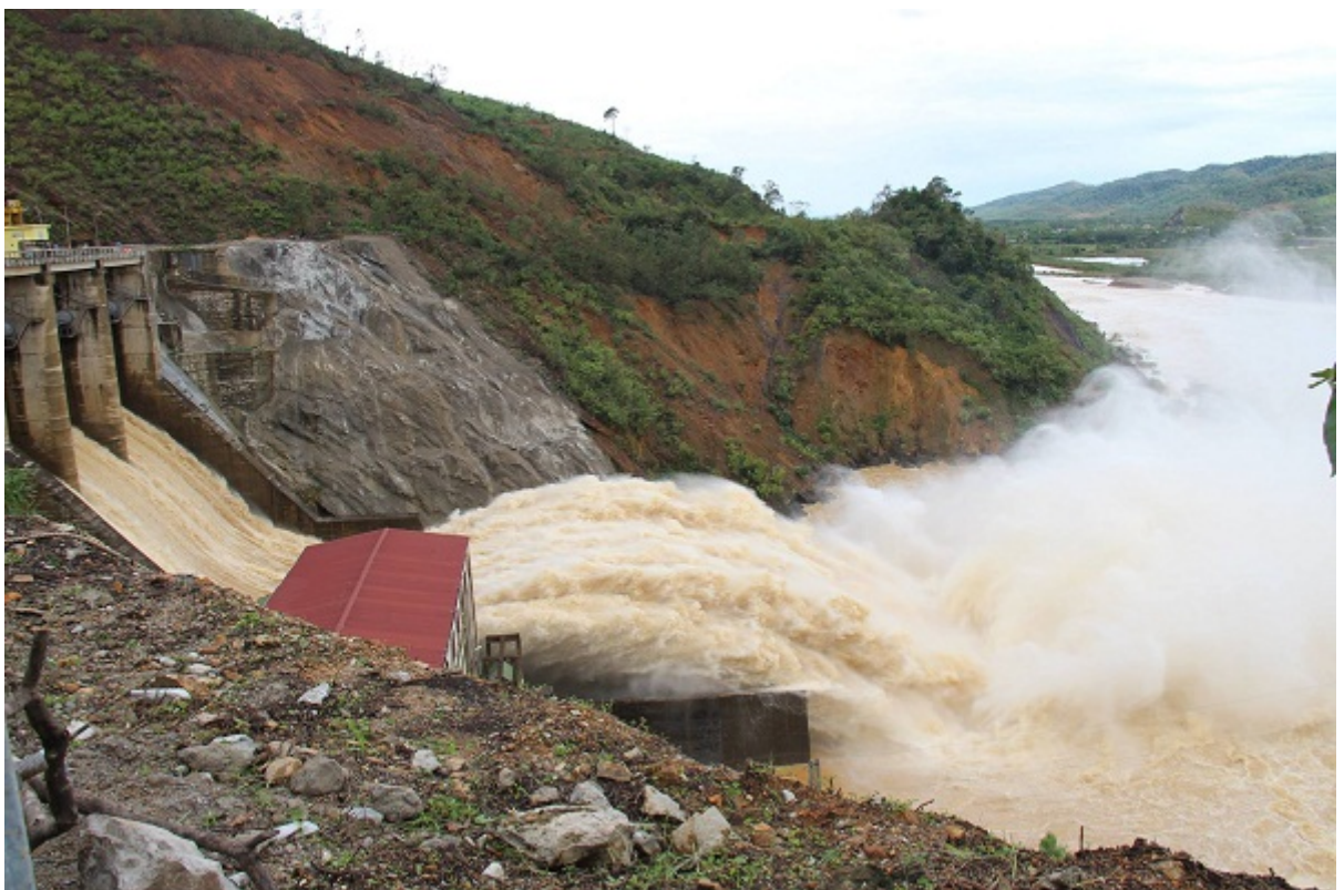
Thủy điện Hố Hô (huyện Hương Khê) xả lũ
