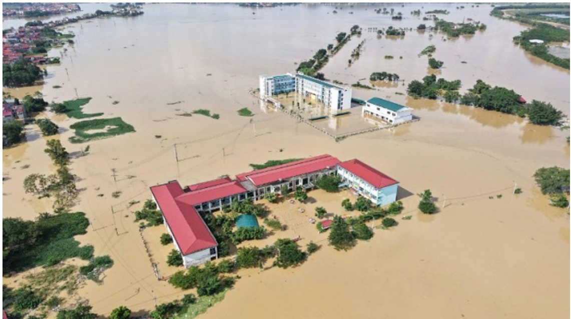
Mưa lũ đã làm nhiều công trình tại Bắc Ninh bị ngập sâu. Ảnh: An Trân
