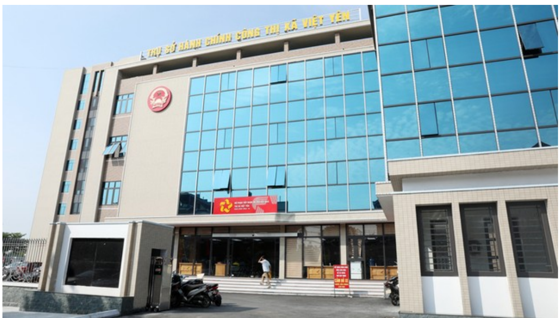
Trụ sở Trung tâm hành chính công thị xã Việt Yên (Bắc Giang)
