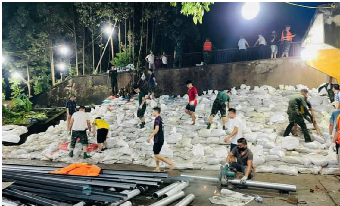
Các lực lượng xuyên đêm gia cố, đảm bảo an toàn Trạm bơm Cống Bún.
