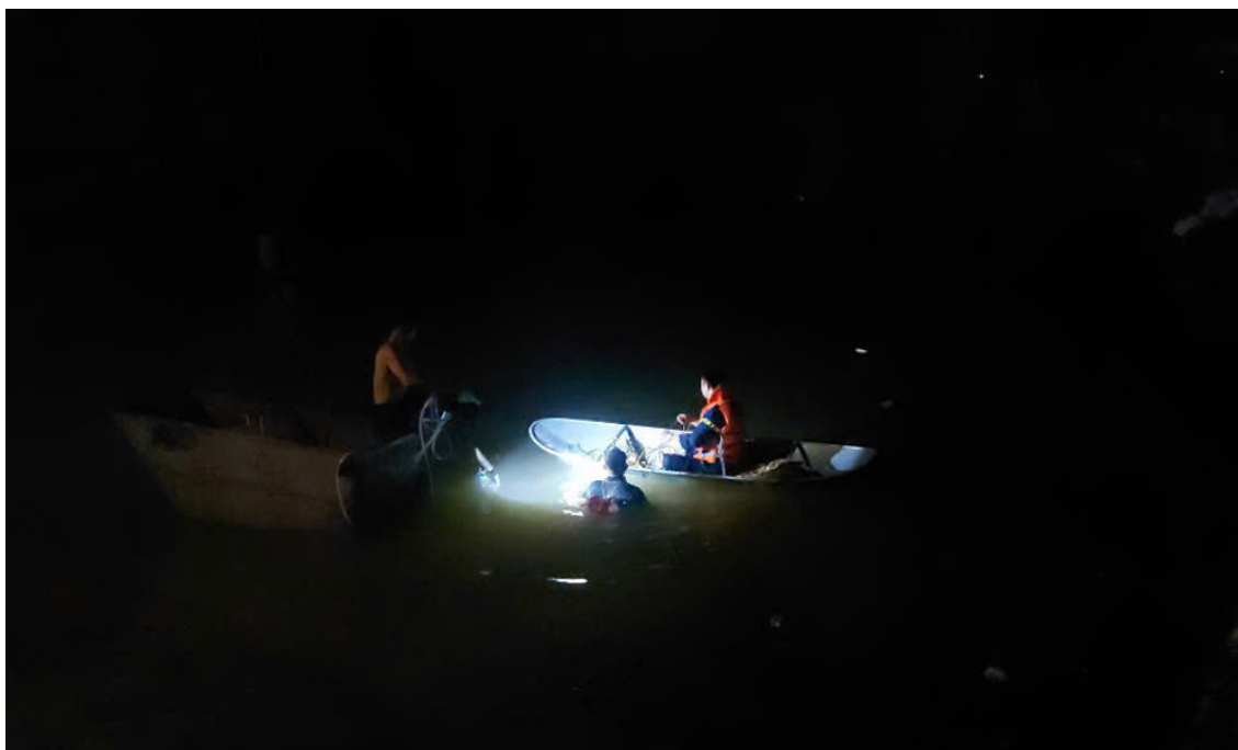
Người nhái lặn xuống kiểm tra cánh cổng Trạm bơm Cống Bún.
