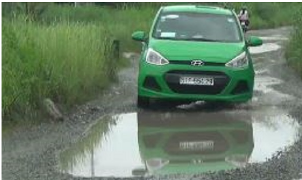
Đường xuống cấp, hư hỏng, chậm khắc phục
