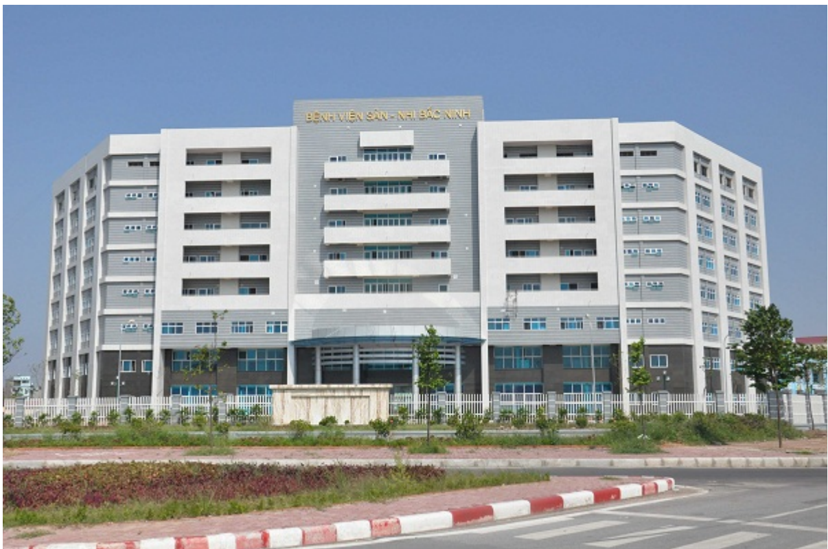
Bệnh viện Sản - Nhi tỉnh Bắc Ninh
