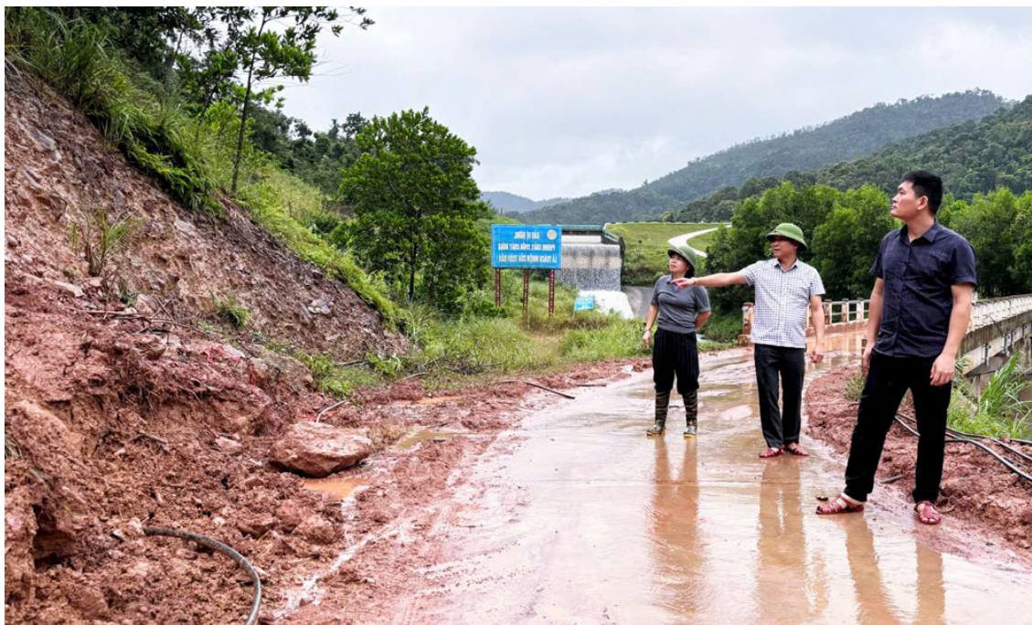
Lãnh đạo xã Dương Hưu kiểm tra vị trí sạt lở trên đường vào hồ Khe Chảo.
