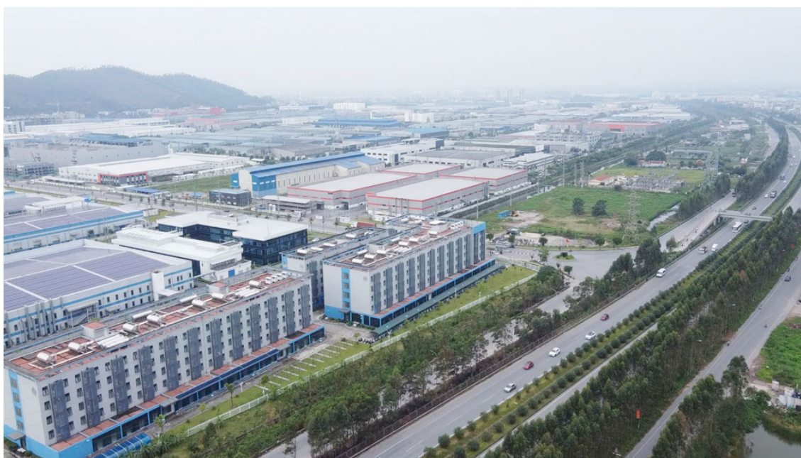
Khu công nghiệp Vân Trung
