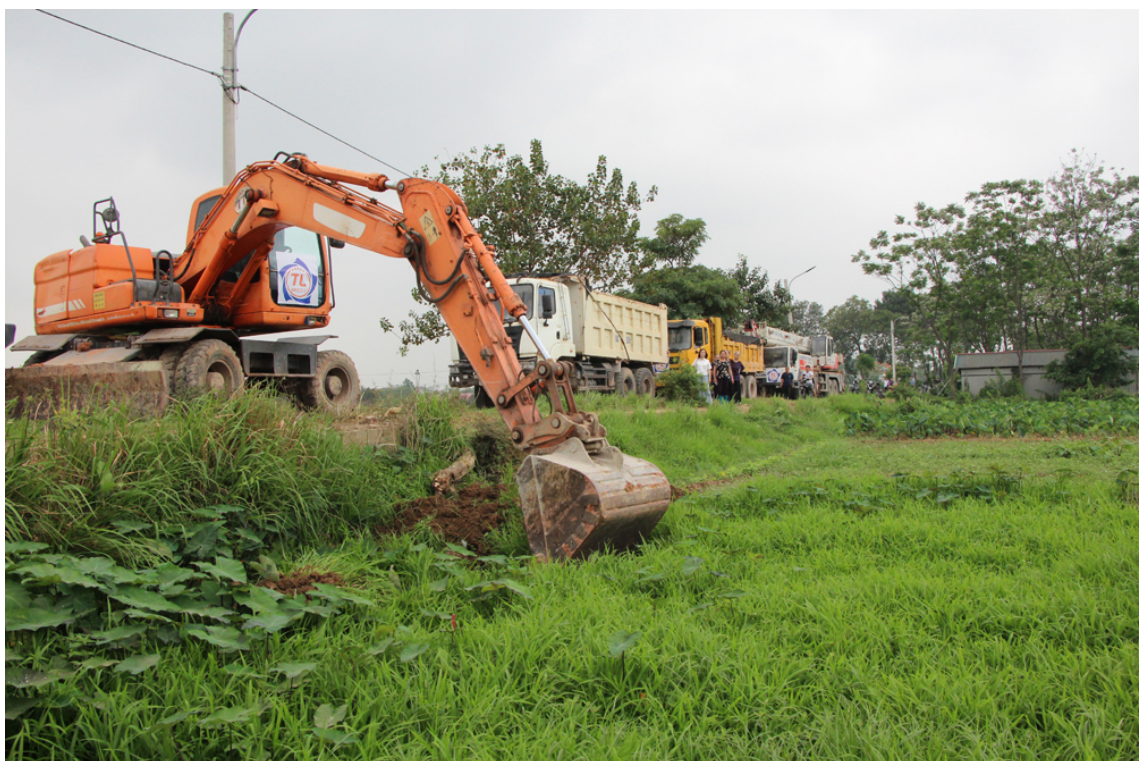
Đơn vị thi công tập trung phương tiện để thi công cầu Vân Hà.
