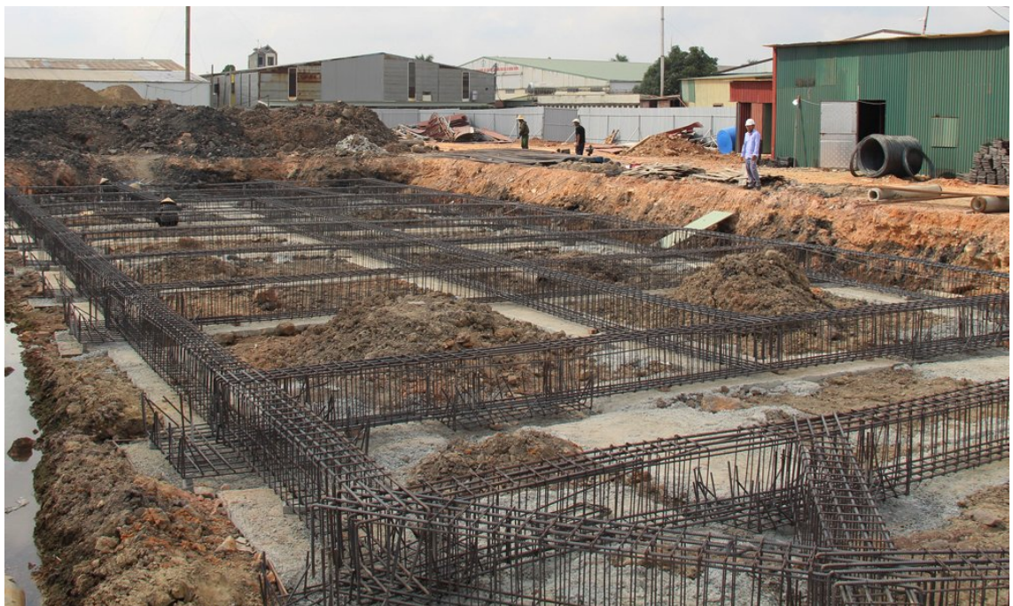
Thi công phần móng và ghép cốt thép tại công trình nhà thờ Ngô Thôn.
