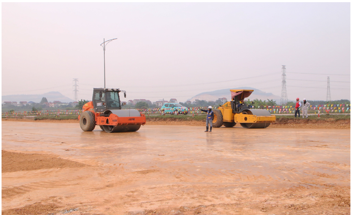
Các nhà thầu đang đẩy nhanh tiến độ thi công Cụm công nghiệp Trung Sơn - Ninh Sơn, phường Vân Hà.
