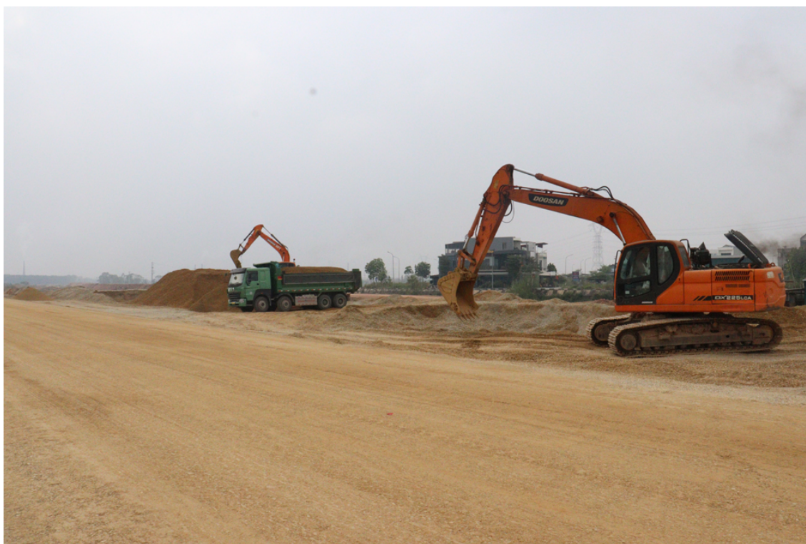
Đơn vị thi công đang tích cực thi công tuyến đường Vành đai 4 (đoạn qua địa bàn tỉnh Bắc Ninh)
