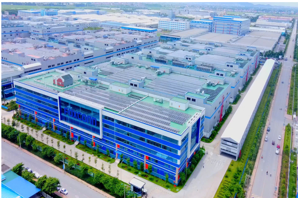
Khu Công nghiệp Quang Châu.
