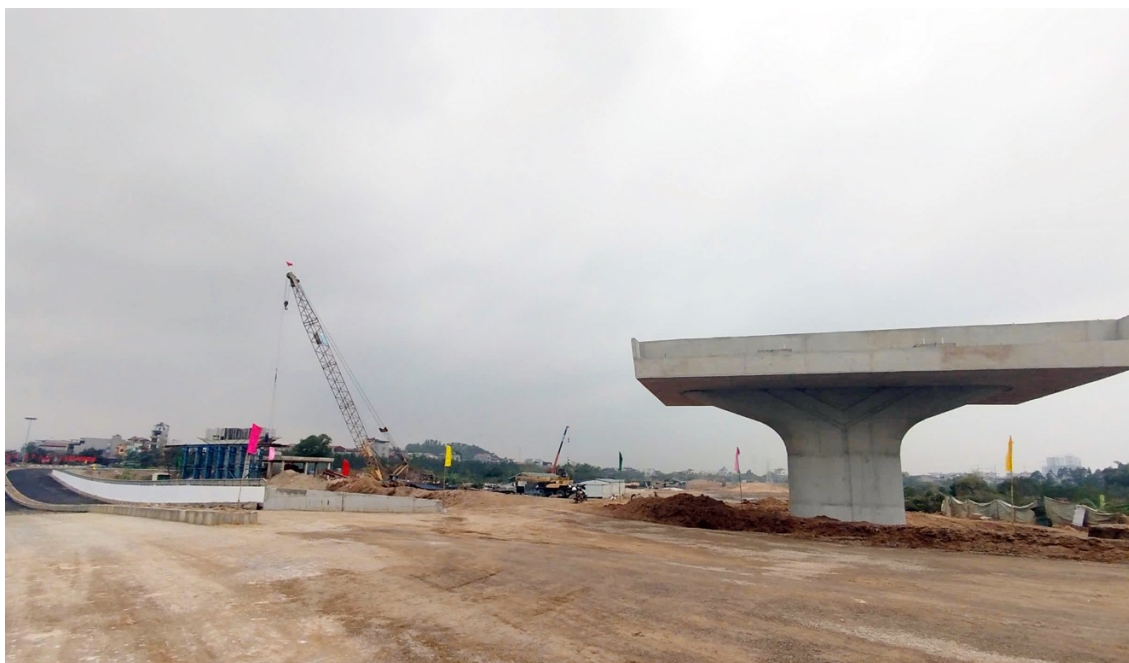
Đường Vành đai 4 địa phận Bắc Ninh.
