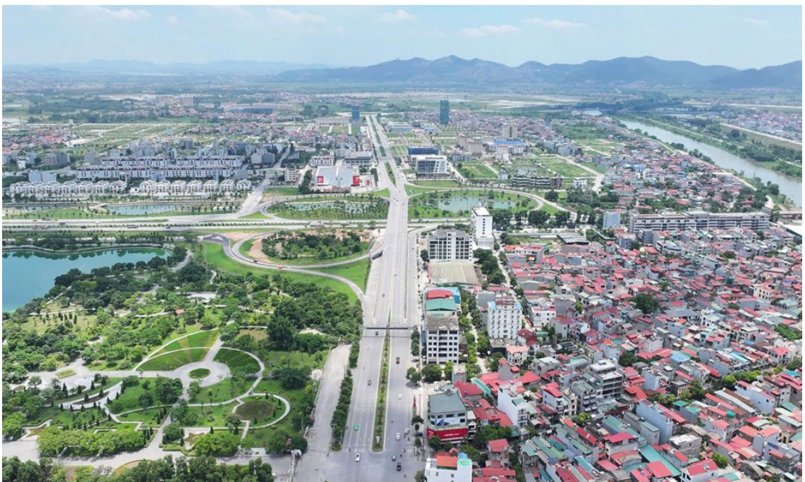
Một góc hạ tầng giao thông, đô thị Bắc Ninh.
