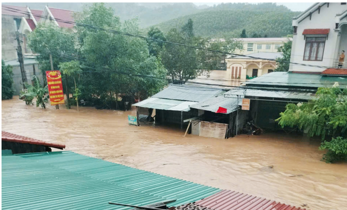
Thôn Linh Phú, xã Tuấn Đạo bị thiệt hại nặng do mưa lũ.
