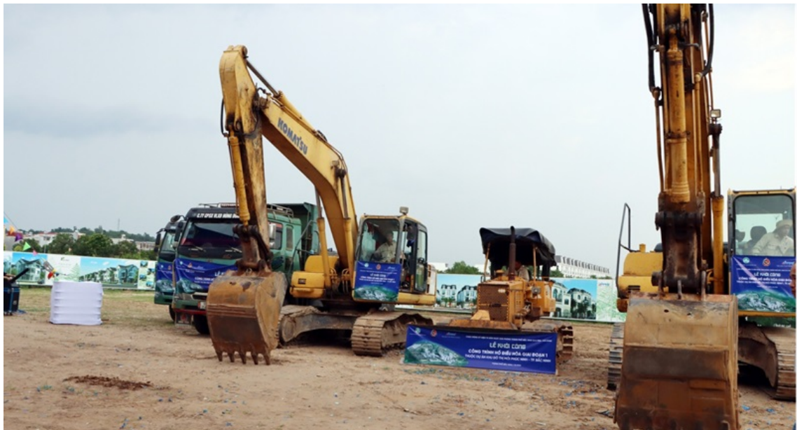
Khởi công dự án hồ điều hòa Phúc Ninh (giai đoạn 1)
