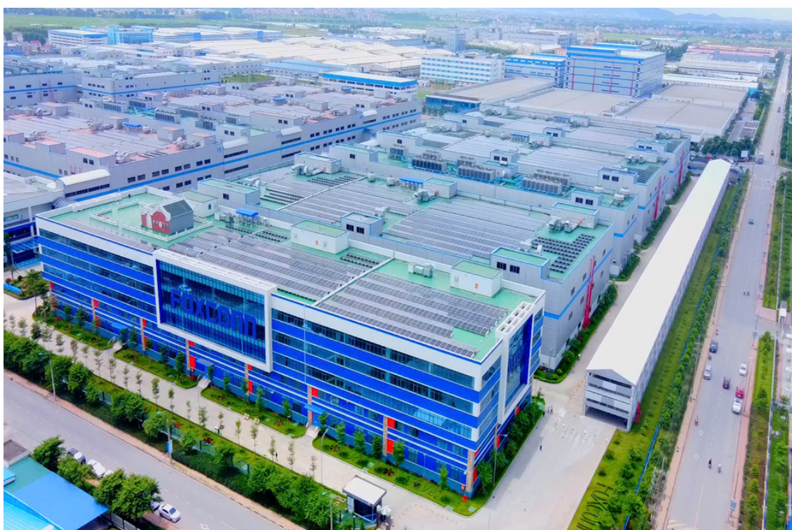
Khu công nghiệp Quang Châu.
