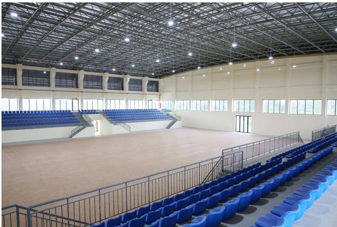
Các hạng mục trong Nhà thi đấu Từ Sơn đã cơ bản hoàn thiện
