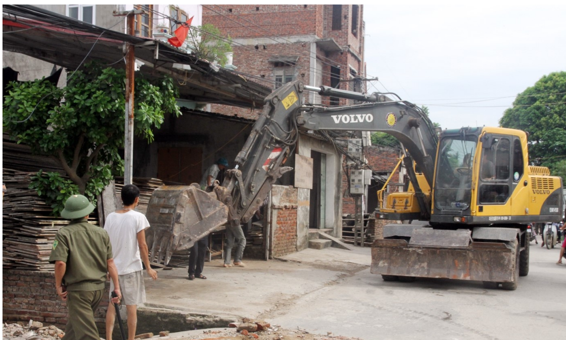
Lực lượng chức năng tháo dỡ công trình vi phạm hành lang đê
