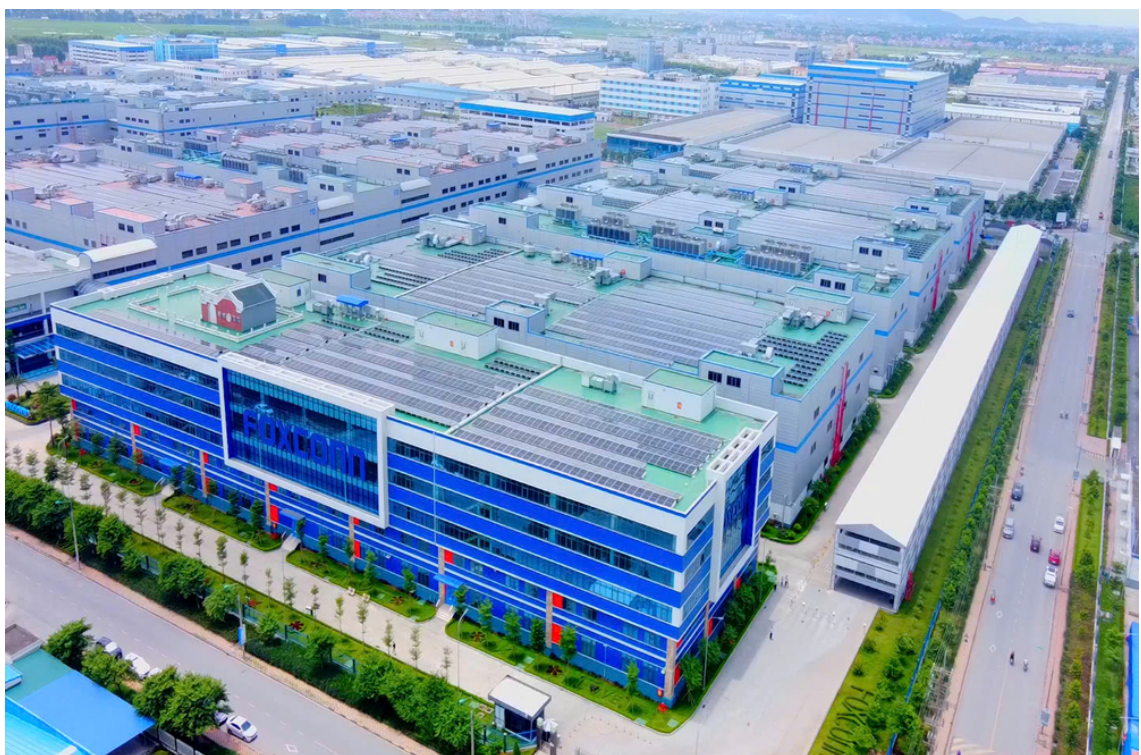
Khu công nghiệp Quang Châu.
