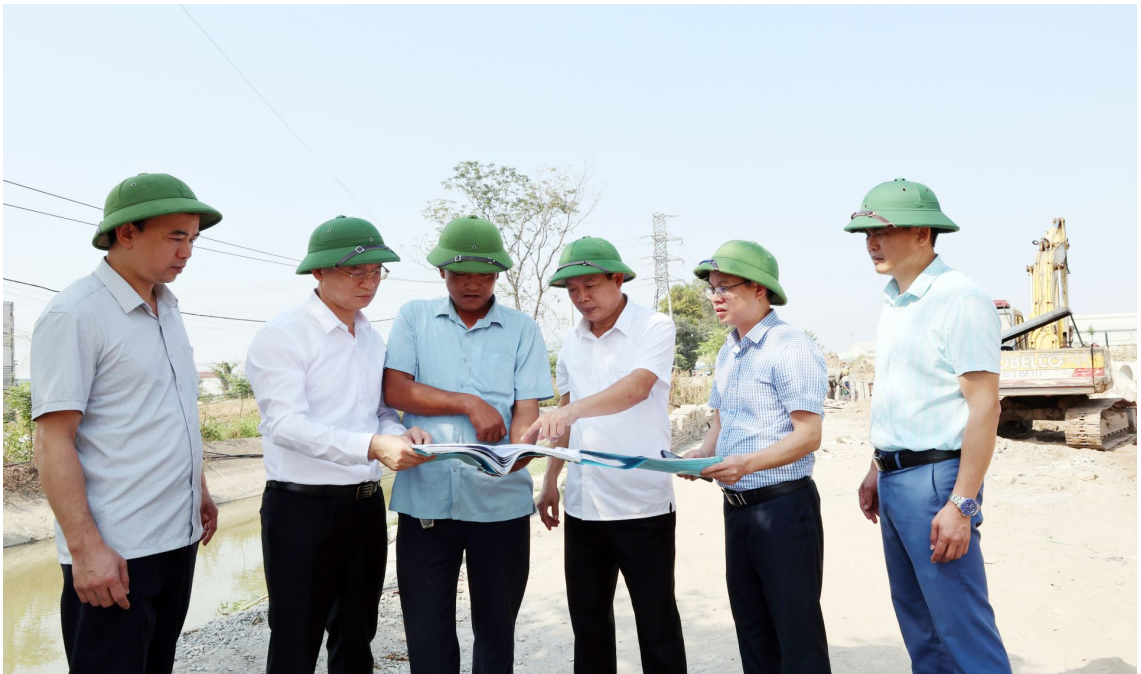
Lãnh đạo phường kiểm tra tiến độ thi công dự án đường giao thông xã Phượng Mao từ ĐT.279 đi Khu công nghiệp Quế Võ I.
