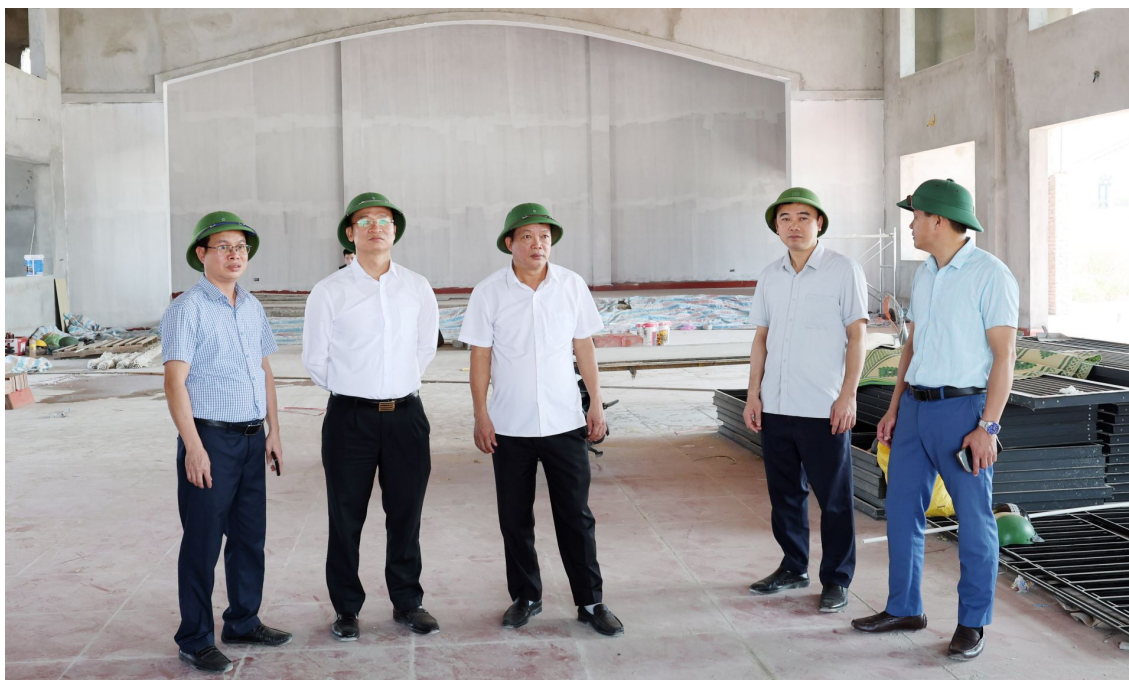
Lãnh đạo phường kiểm tra tiến độ thi công dự án Nhà văn hóa thôn Yên Giả.
