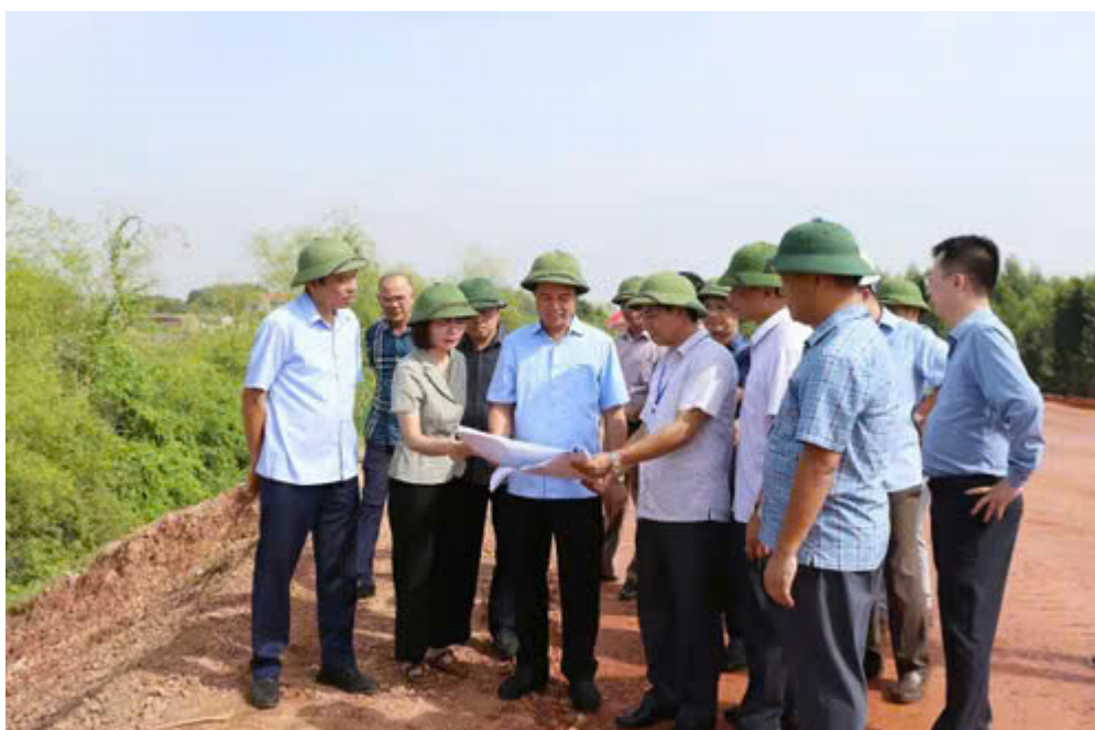
Phó Chủ tịch UBND tỉnh Bắc Ninh Lê Xuân Lợi (Thứ 3 từ trái qua) kiểm tra sự cố sạt lở đê tại xã Mỹ Thái
