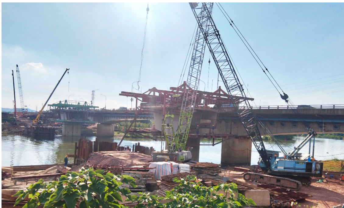
Nhà thầu đẩy nhanh tiến độ thi công cầu Xương Giang.
