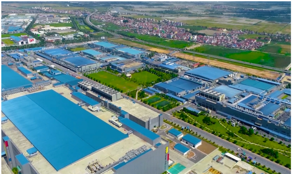
Khu công nghiệp Yên Phong II A
