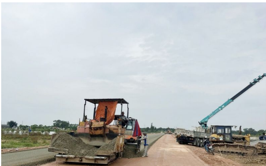
Thi công đường vành đai 4 đoạn qua địa phận tỉnh Bắc Ninh.
