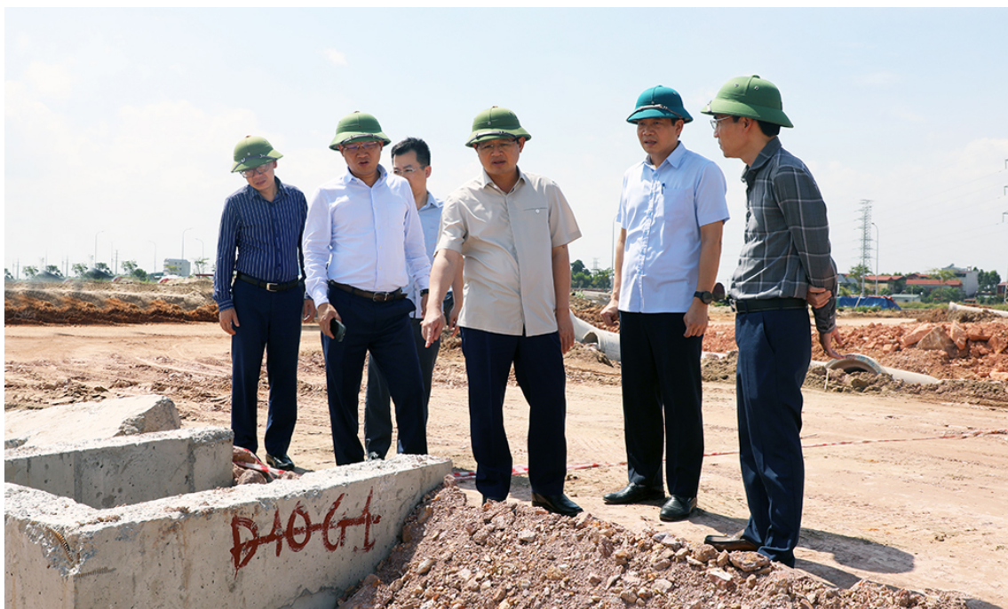
Chủ tịch UBND tỉnh kiểm tra tiến độ thi công hạ tầng khu tái định cư xã Gia Bình.
