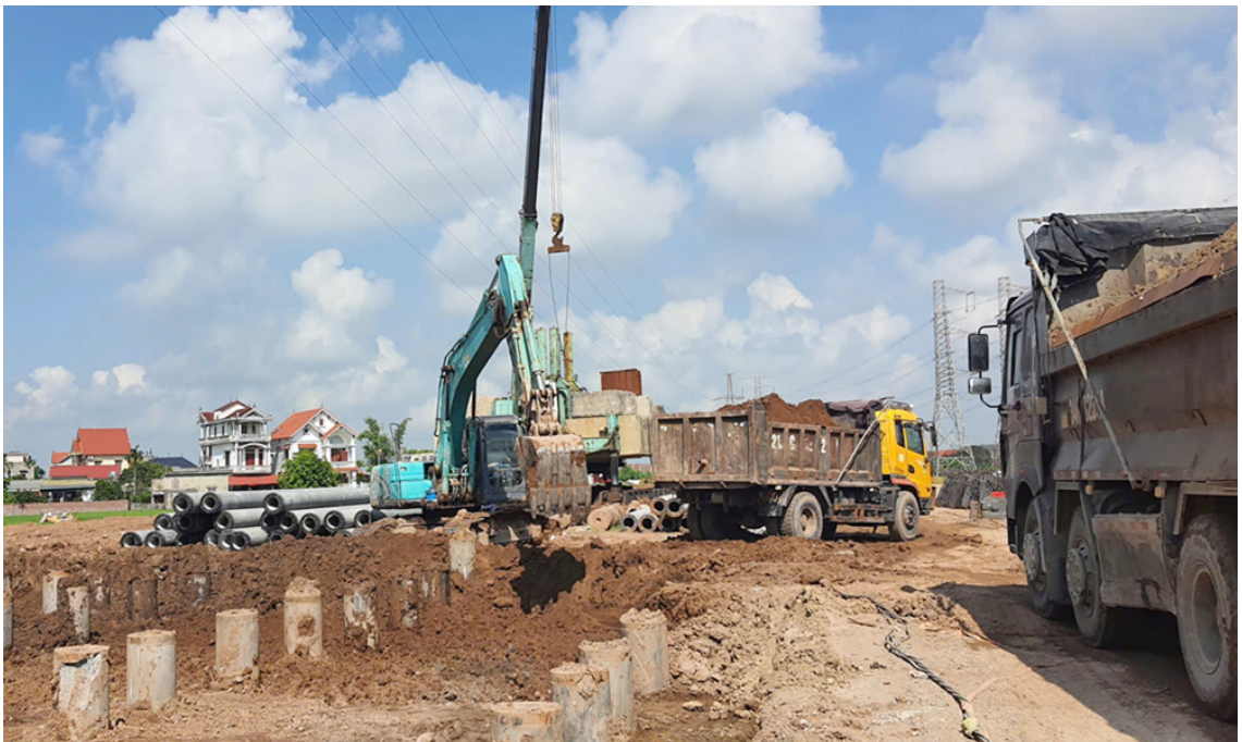
Thi công dự án xây dựng cầu Kênh Vàng và đường dẫn hai đầu cầu.
