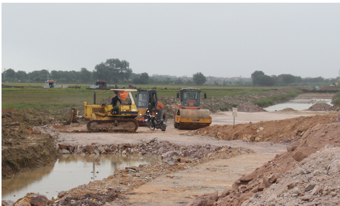
Thi công đường tỉnh 285B đoạn qua xã Tâm Giang.
