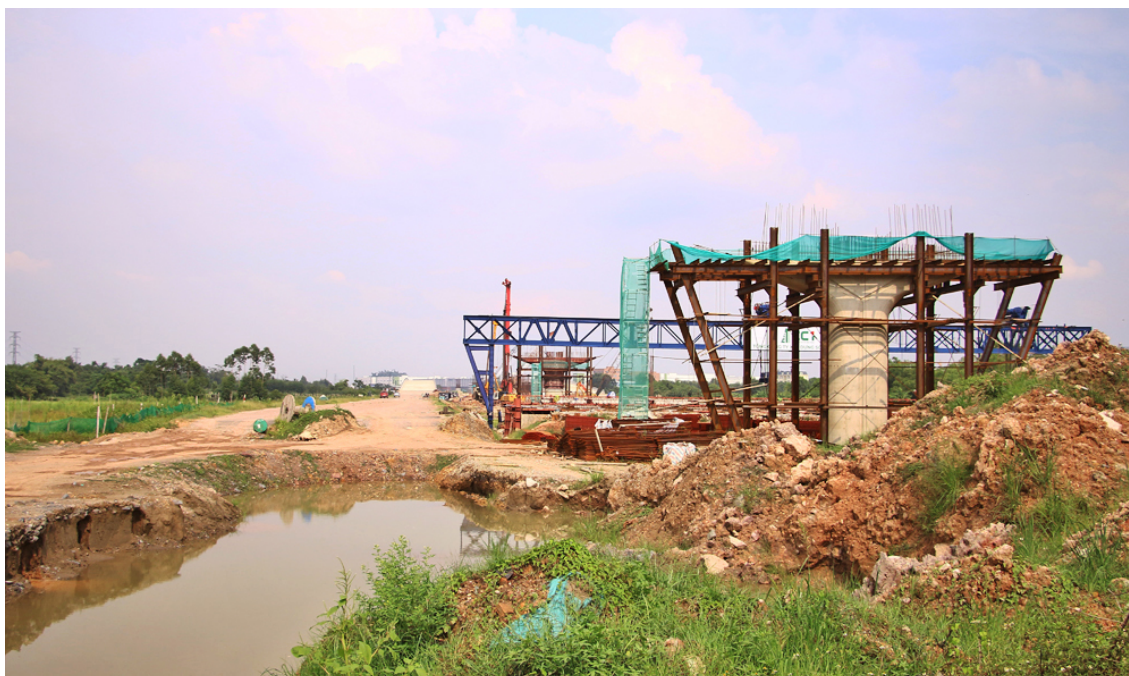
Dự án đường Vành đai 4 - Vùng Thủ đô Hà Nội (đoạn qua địa phận tỉnh Bắc Ninh) đang được thi công.
