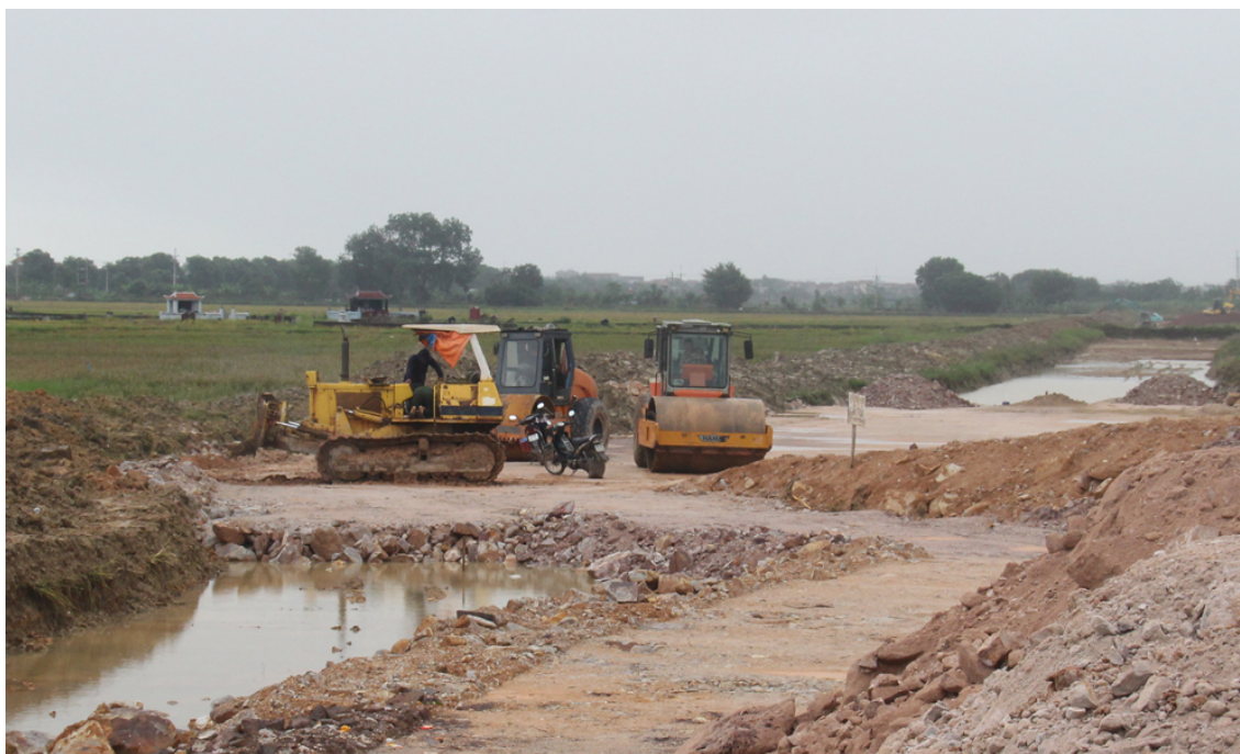
Thi công dự án đường tỉnh 285B đoạn qua xã Tam Giang.
