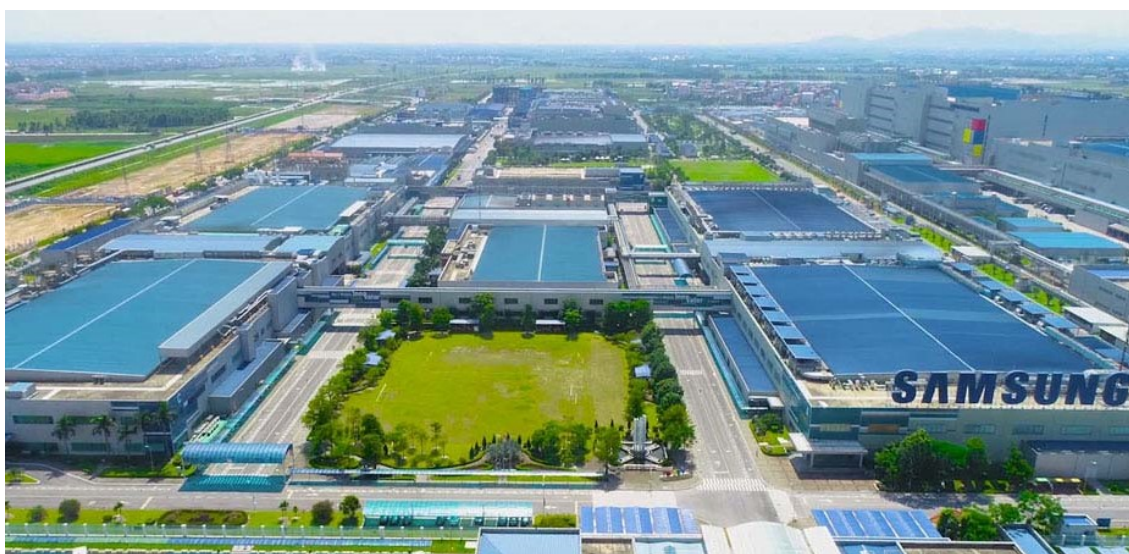
Khu công nghiệp Yên Phong.
