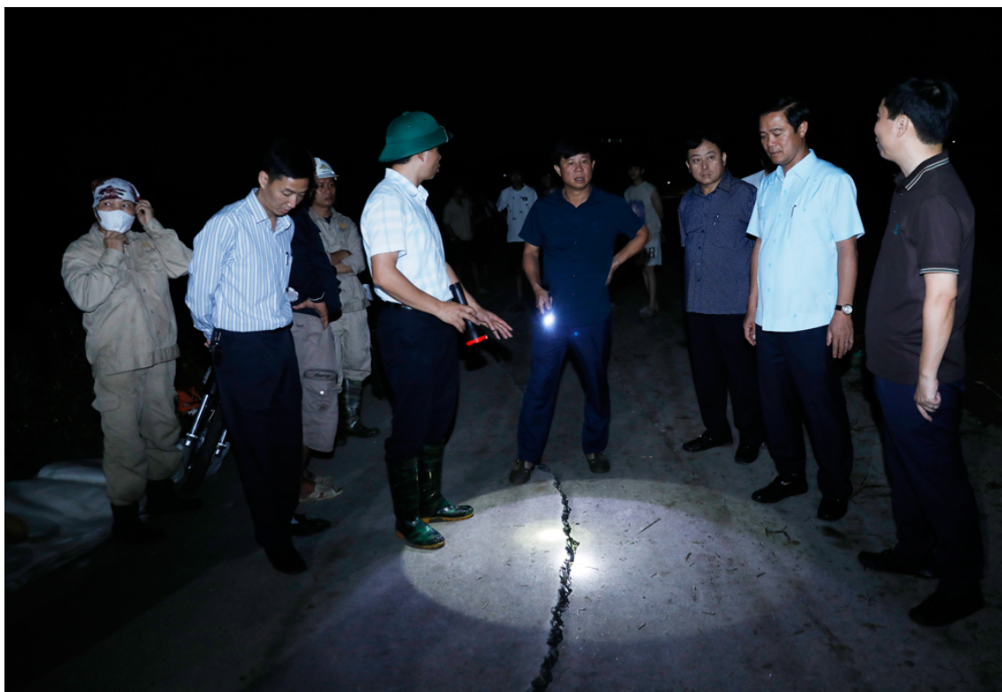
Các đồng chí: Phạm Đức Luận, Lê Xuân Lợi kiểm tra công tác chống lũ tại tuyến đê tả Cầu qua địa bàn thôn Mai Hạ, xã Xuân Cẩm rạng sáng 9/10.
