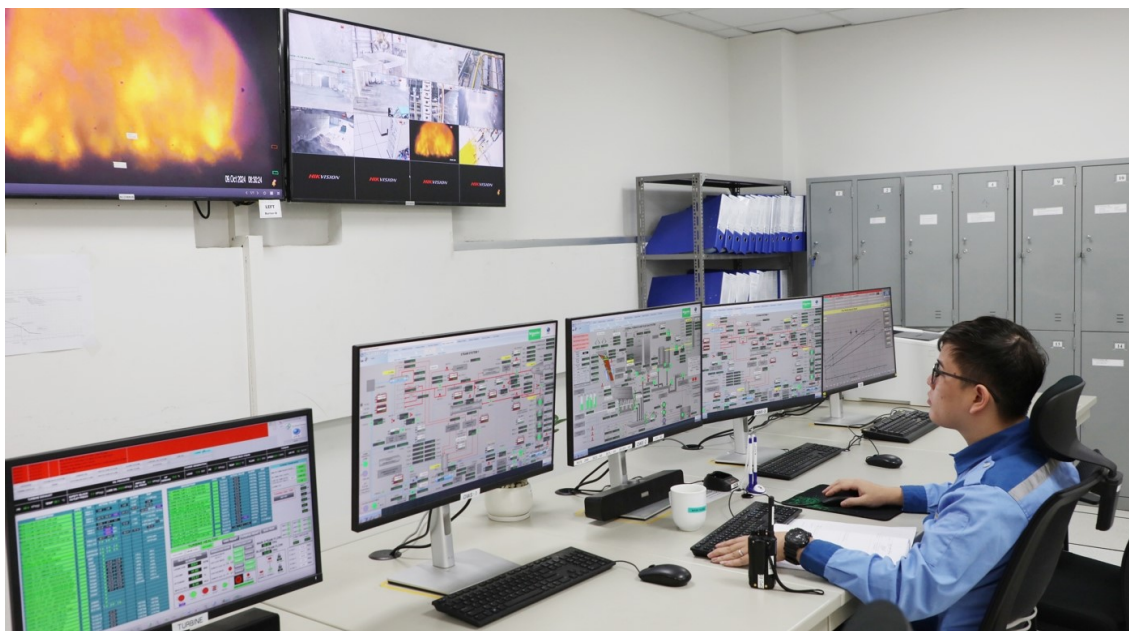
Khu điều hành trung tâm Nhà máy đốt rác phát điện thị xã Thuận Thành.
