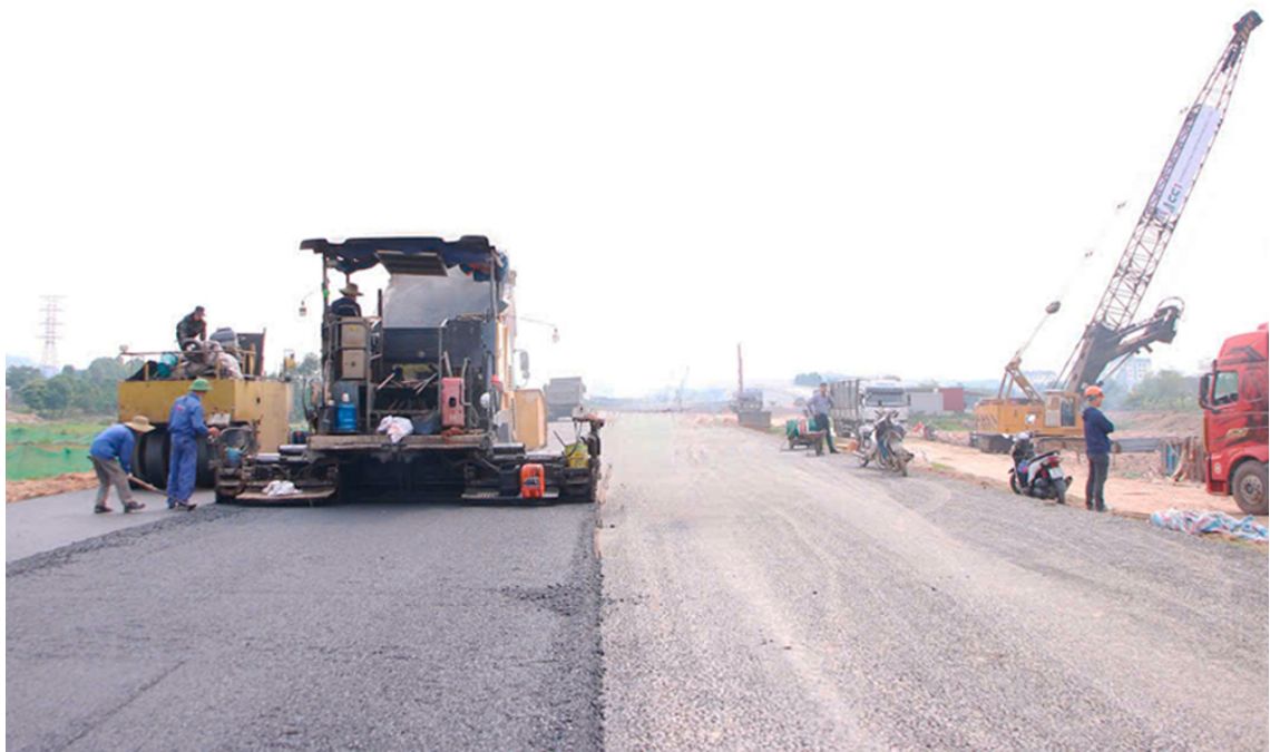
Nhà thầu thi công dự án đường Vành đai 4 - Vùng Thủ đô Hà Nội qua địa bàn phường Hạp Lĩnh.
