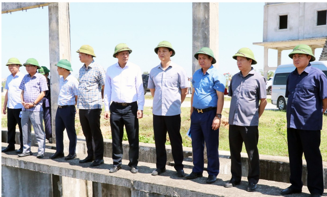
Chủ tịch UBND tỉnh Vương Quốc Tuấn (thứ 4 từ phải qua) kiểm tra Dự án cải tạo nâng cấp trạm bơm Hữu Chấp, phường Hòa Long, thành phố Bắc Ninh
