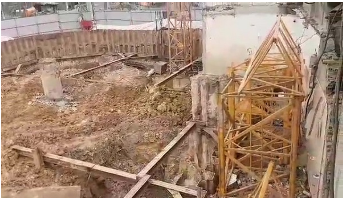
Bên trong công trình đang thi công dở dang
