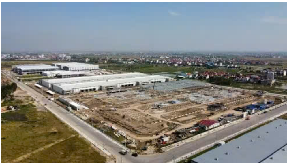
Khu công nghiệp Thuận Thành 3
