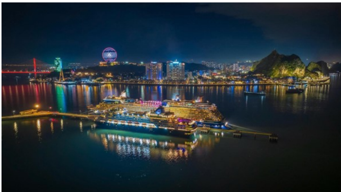
Cảng tàu khách quốc tế Hạ Long góp phần hoàn thiện hạ tầng giao thông khu vực. Ảnh: Ánh Dương
