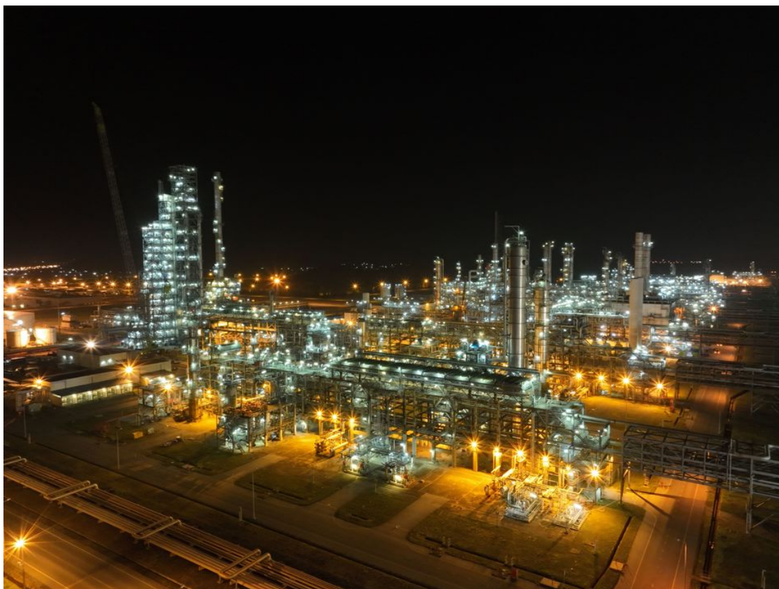
Nhà máy lọc hóa dầu Nghi Sơn
