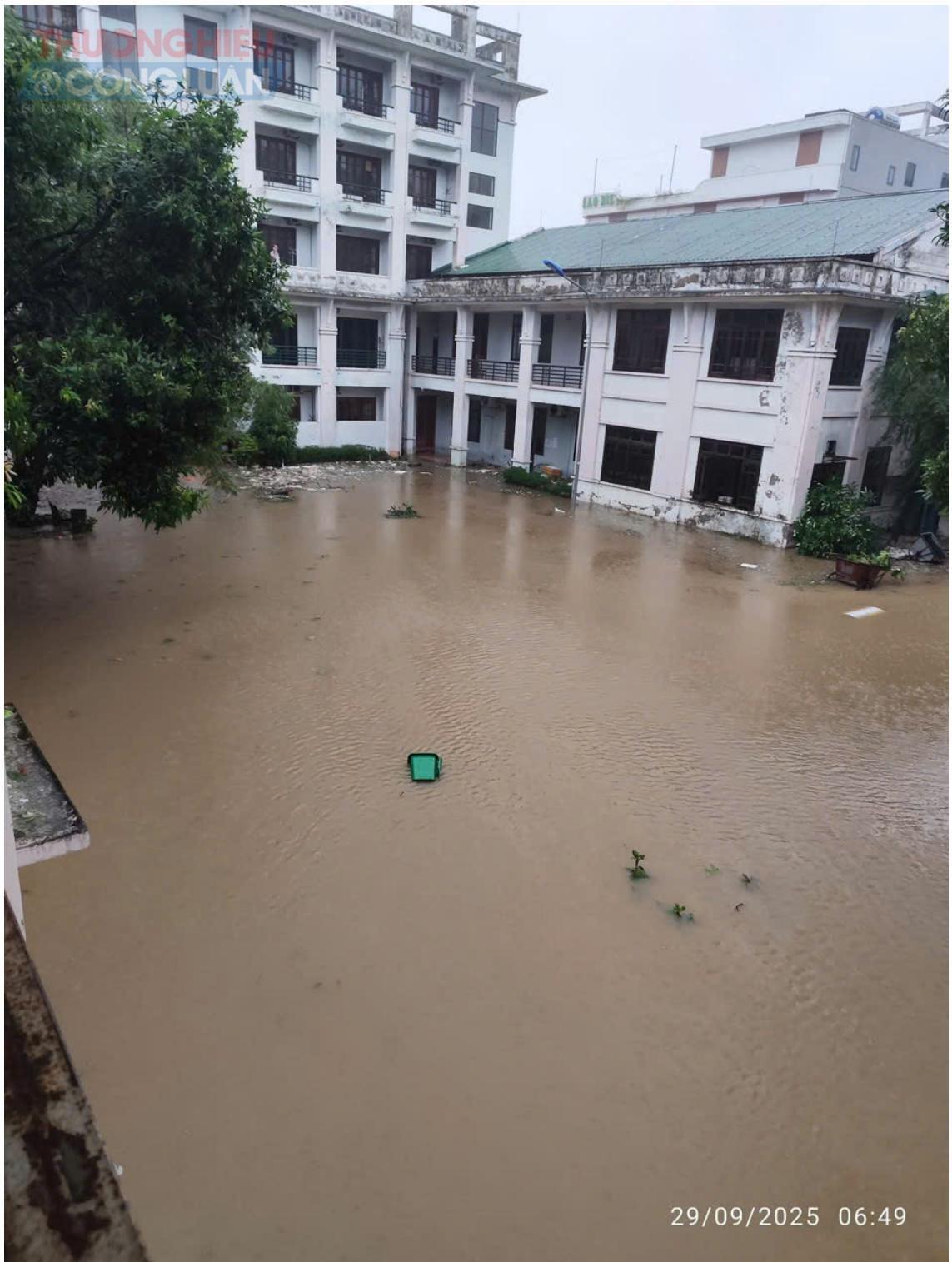
Tại Nghê An, mưa lớn kéo dài khiến nhiều tuyến đường ngập sâu, giao thông ách tắc cục bộ.
