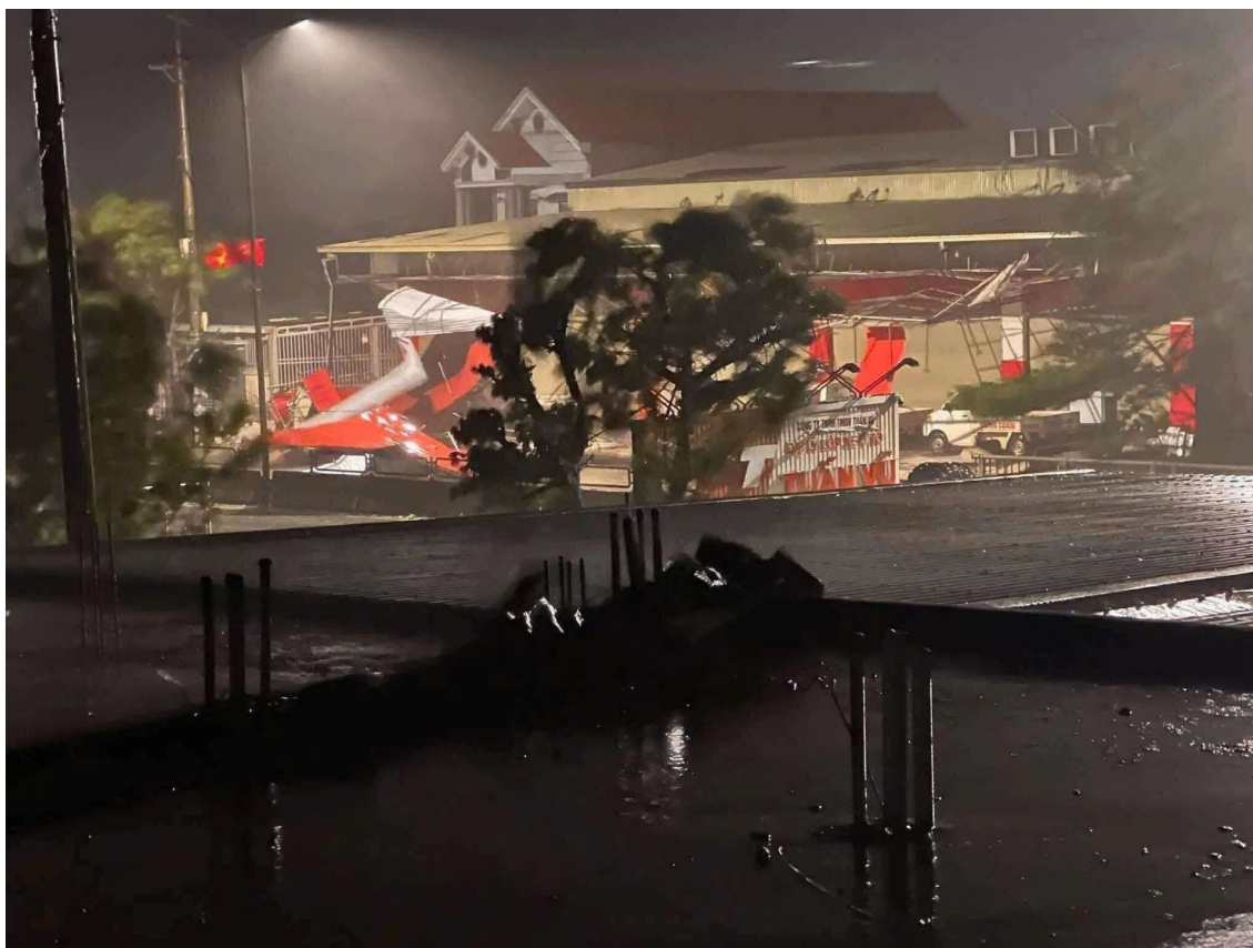
Nhiều công trình bị đổ sập
