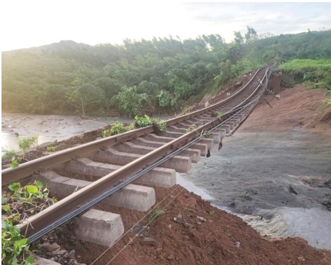
Hiện trạng tuyến đường sắt Bắc - Nam tại Km 1136+800 đến Km1136+900 đoạn qua xã Xuân Lãnh, tỉnh Đắk Lắk.
