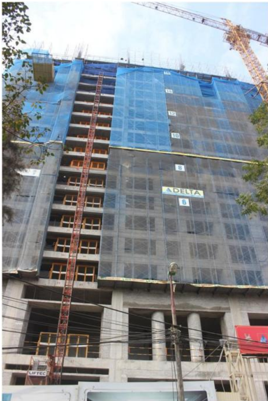
Nhà thầu Delta đang thi công tầng 18
