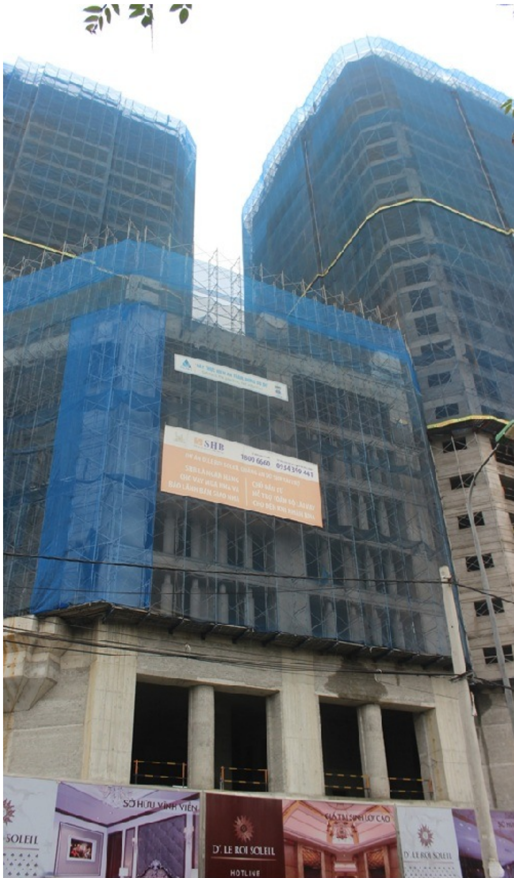
Dự án D'. Le Roi Soleil hoàn thành việc cất nóc vượt tiến độ 1 tháng
