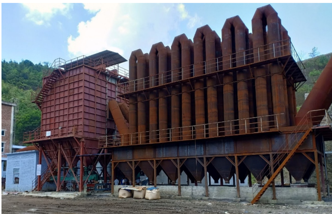
Nhà máy điện phân chì kẽm của Công ty Ngọc Linh.
